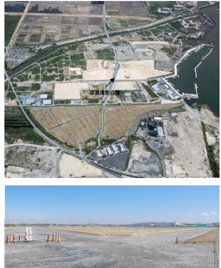
(工事地区現況)
