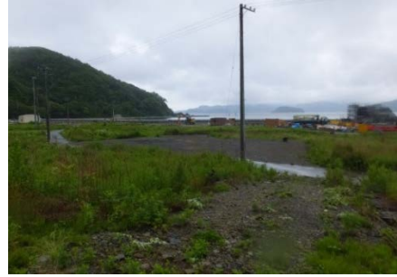
(工事地区現況)
