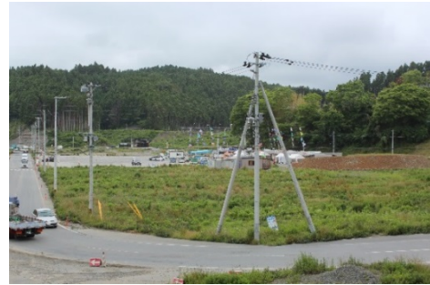
(工事地区現況)
