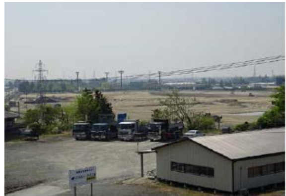
(造成工事の状況)
